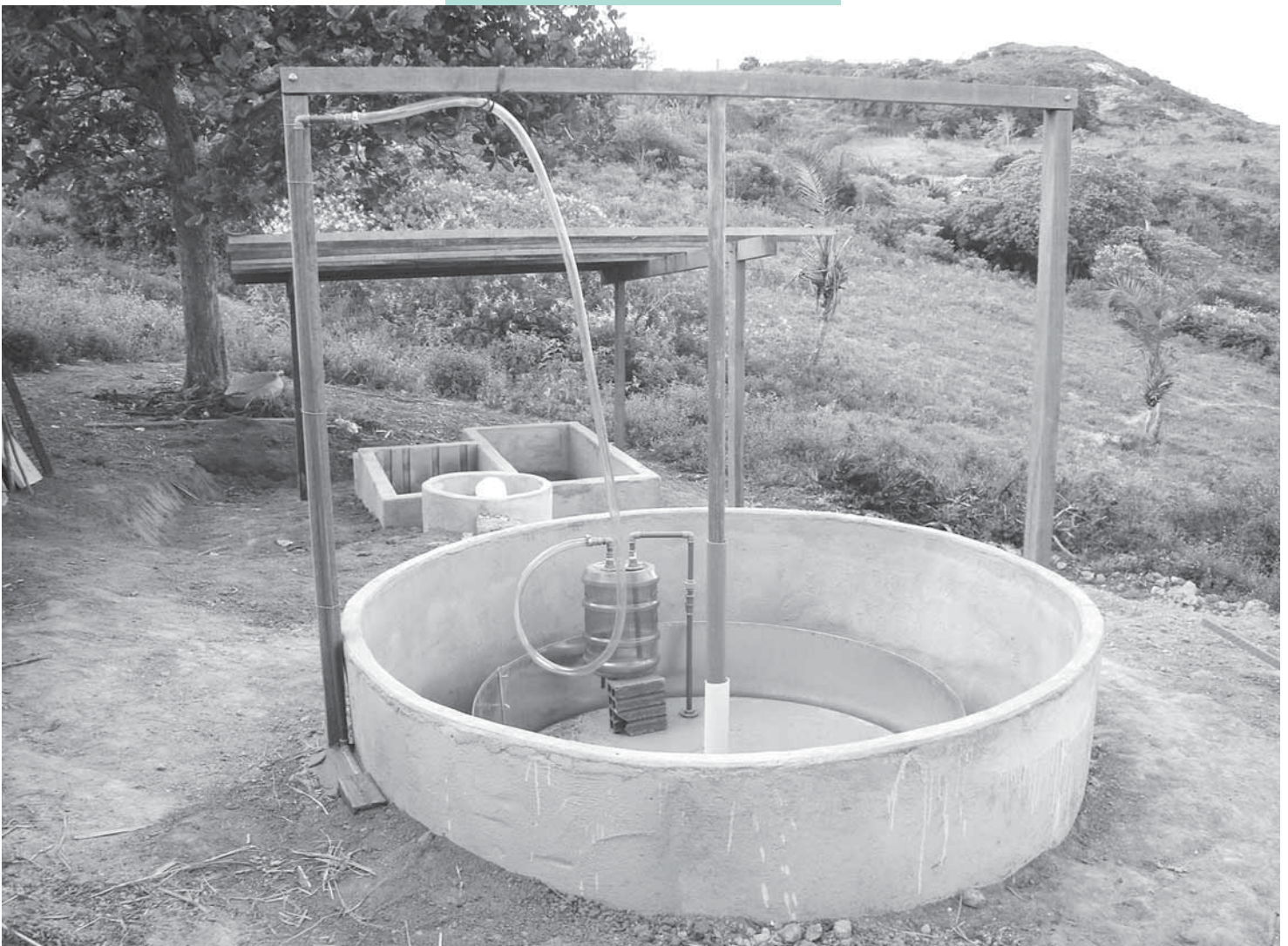
Erste Baustelle Biogasanlage in Sobrado vollendet
